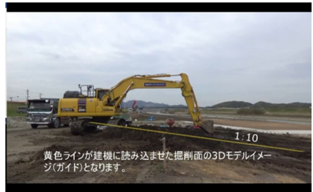
図-11 ガイドに沿って掘削している様子
