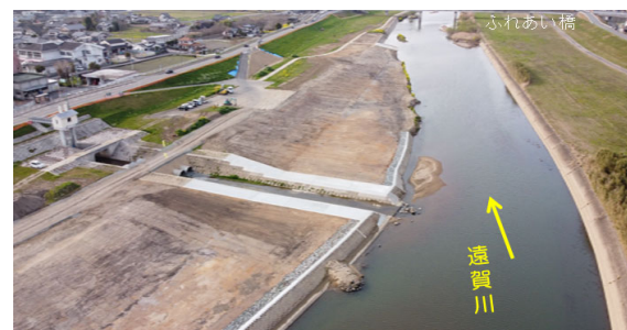
図-14 小竹地区工事完成（2021年3月）
