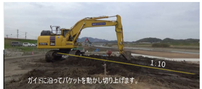
図-5 ICT施工状況
