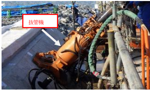
図-23 抜管機設置状況
