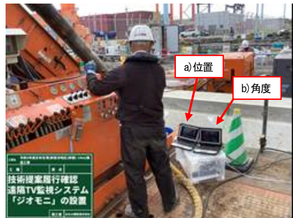
図-10 ジオモニ設置(削孔機側モニター)
