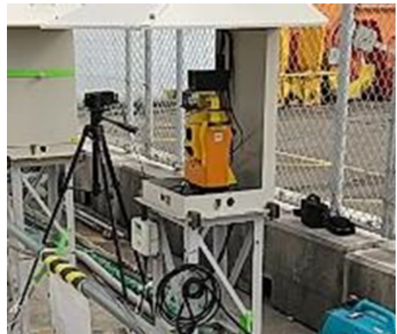
図-9 ジオモニ設置
