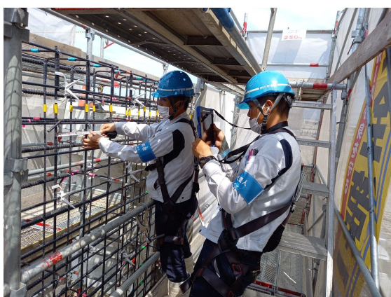
写真 4 遠隔臨場状況（受注者）
