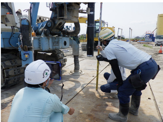
写真 3 遠隔臨場状況（受注者）
