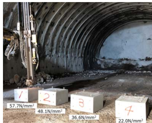
写真-1 コンクリート削孔試験状況
