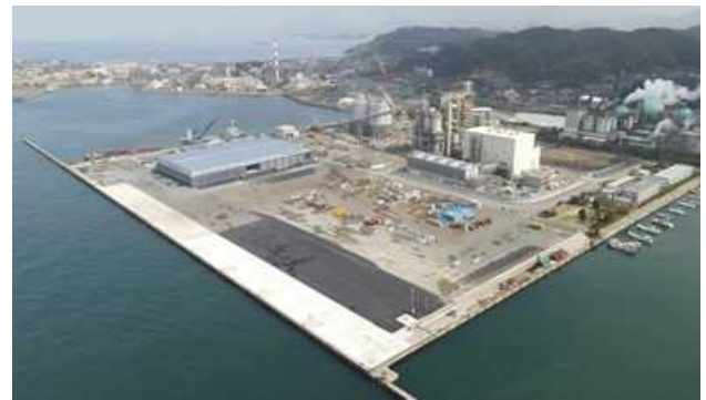
図-24 完成写真 (R3.3 撮影)
