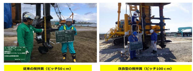
図-20 攪拌翼のピッチ改良
