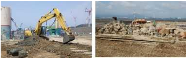
図-21 事前掘削による転石等除去状況
