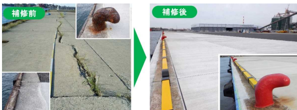
図-23 プロジェクト前後の岸壁状況
