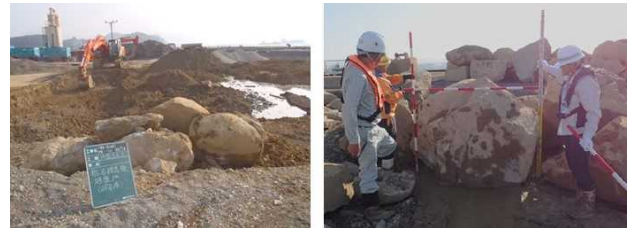
図-10 支障物除去と計測
