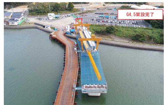
図-9 主桁架設工法（P9-A2例）
