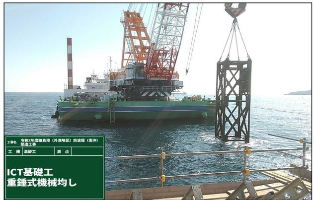
写真-2 櫓型重錘による均し状況
