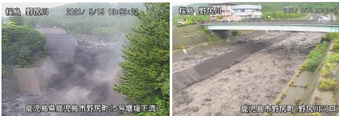
写真-3 土砂流の発生状況 (上流5号堰堤、下流の流路内)
