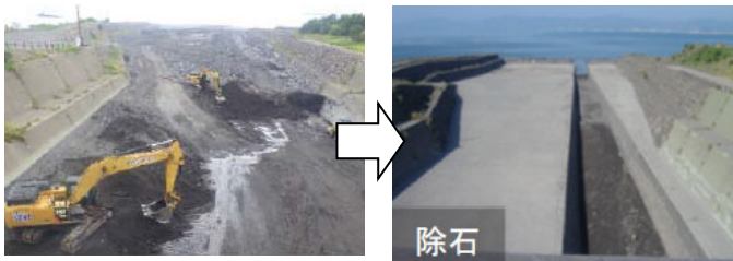
写真-4 流路内の除石作業状況 写真-5 流路内の除石完了
