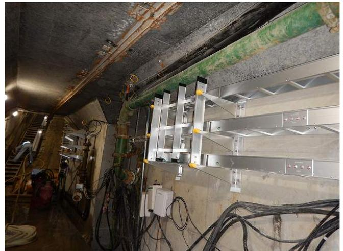
写真-1 ケーブルラックと仮設備の干渉
