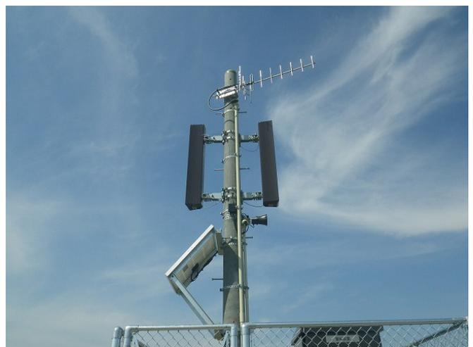
写真-4 採用した長距離スピーカ
