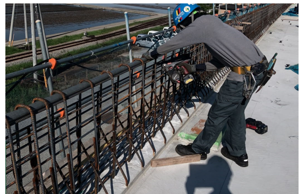
図-8 壁高欄配筋施工状況
