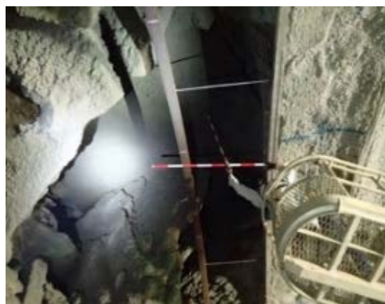
写真-7 大規模空洞の切羽出現状況
