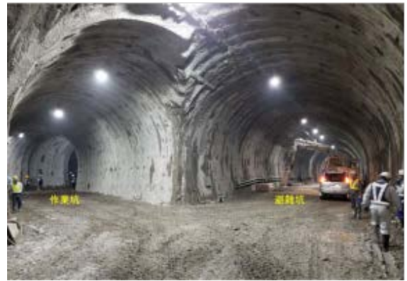
写真-1 避難坑分岐部
