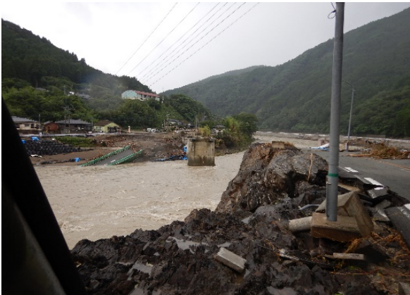
写真-2 鎌瀬橋被災状況
