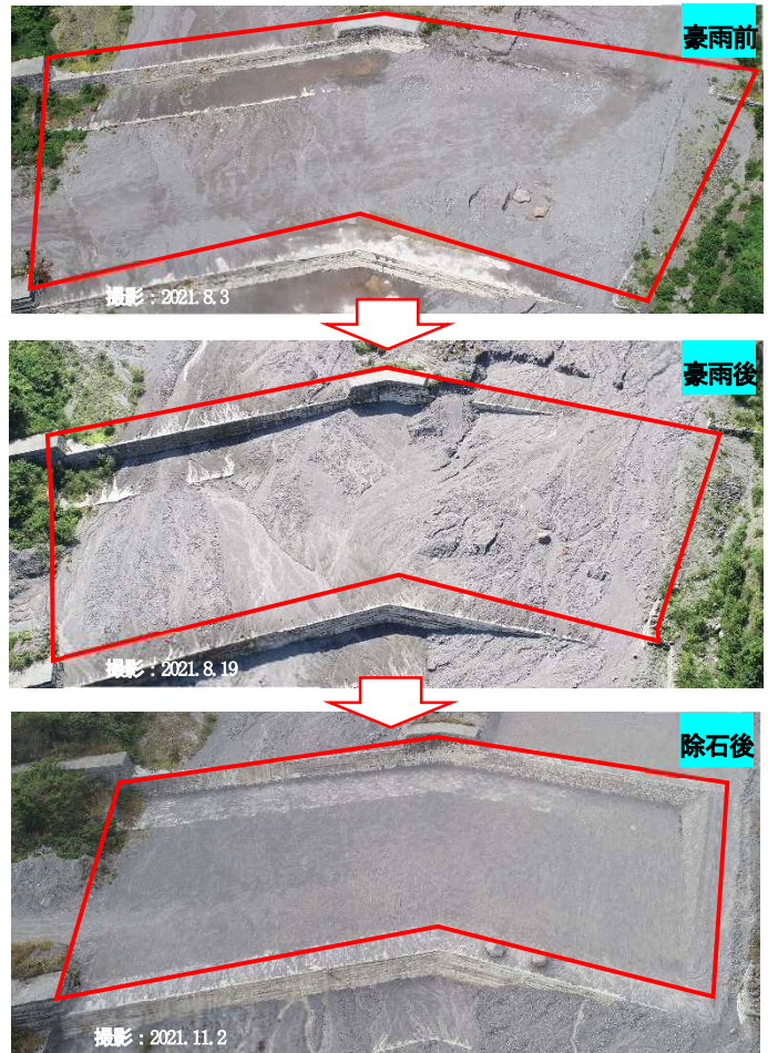
写真-6 除石前と除石後 (赤松谷川8号~9号床固)
