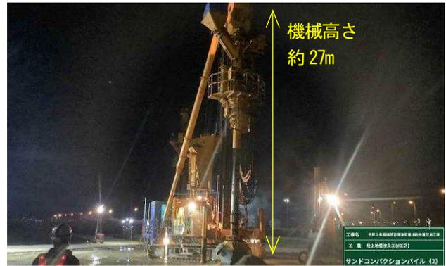
写真-2 SAVE工法の施工状況
