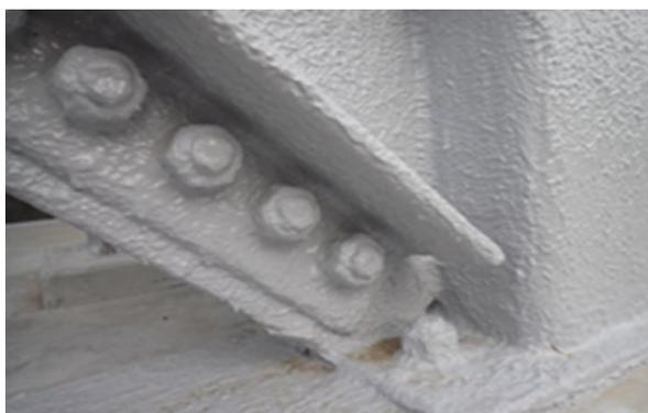
写真-11 耐火塗装の施工
