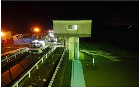
写真-2 ポンプ車による排水状況
