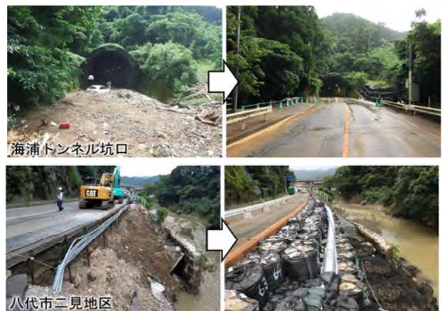
写真-2 道路啓開・応急復旧の実施後の状況
