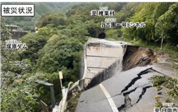
図-4 被災状況②(崩落と路面変状)
