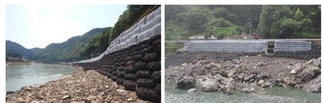
写真-4 崩壊した路肩の応急復旧
