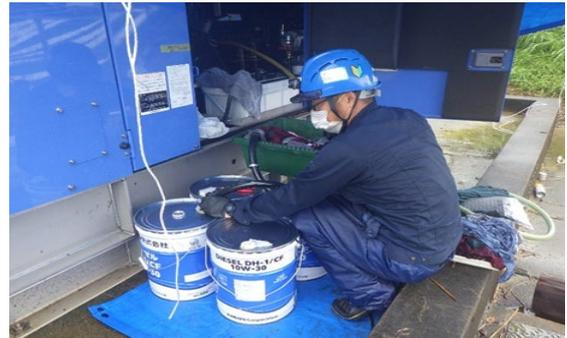
写真-4 発電機エンジンオイル交換状況
