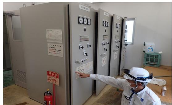
写真-5 操作制御盤の浸水状況
