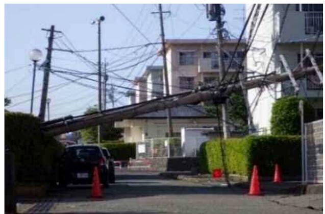
図-1 熊本地震による電柱倒壊事例<sup>1)</sup>
