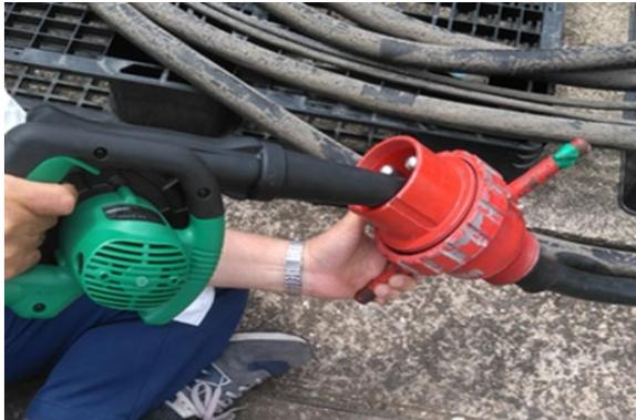
写真-6 ケーブル水分除去・乾燥状況
