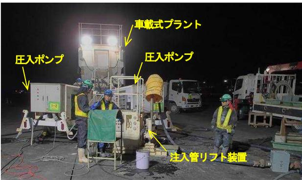
写真-1 CPG工法の施工状況
