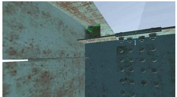
図-13 垂直補剛材の疲労亀裂
