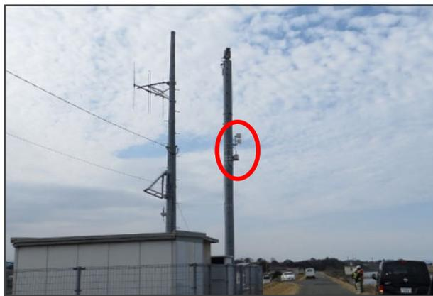
写真-2 現地に設置された K-PASS 基地局とアンテナ
