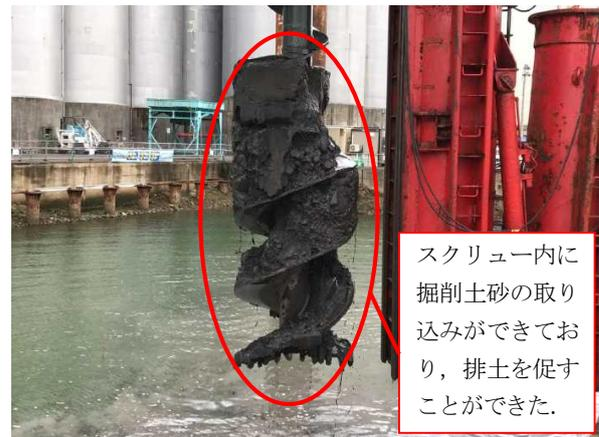
写真-10 内管吊り上げ後
