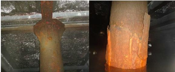
写真-3 鋼管杭の老朽化
