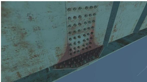
図-9 桁接合部の腐食
