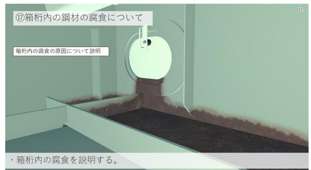
図-14 箱桁内部の腐食
