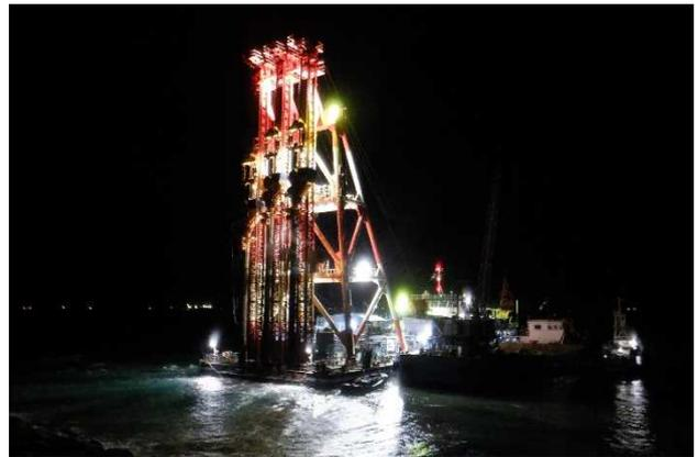
図-11 SCP船による南護岸の地盤改良（夜間施工）
