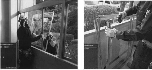
図5 Low-E真空ガラスへの交換作業
