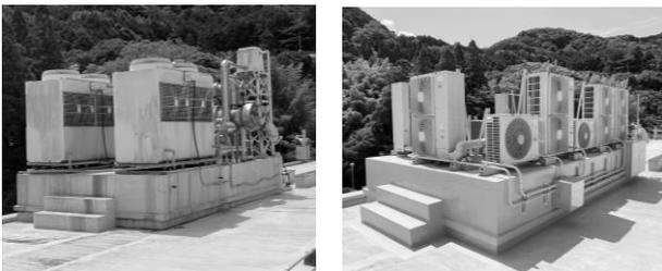
図6 空調設備改修前後(左:改修前、右:改修後)
