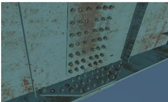
図-11 高力ボルトの脱落
