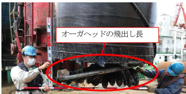
写真-5 飛出し長確認(L=0.45m)
