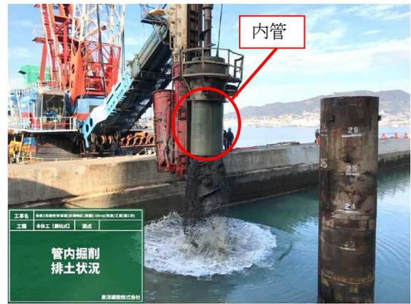
写真-9 内管吊り上げ状況
