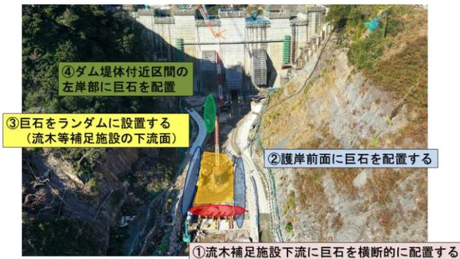
図-11 河床材料の配置イメージ
