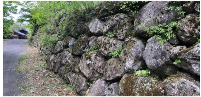
図-6 レキ間に植物が生え自然となじむ護岸（施工事例）
