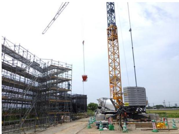
写真-5 橋台躯体の生コンクリート打設状況
