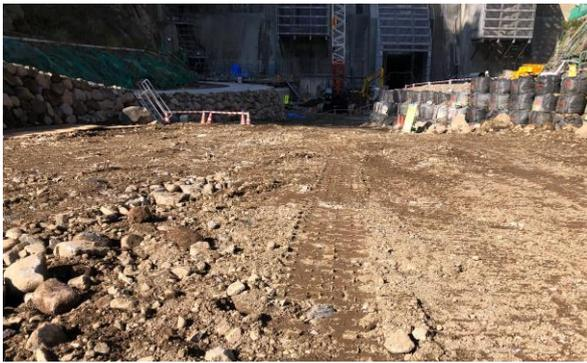
図-9 工事発生土が堆積した河床
