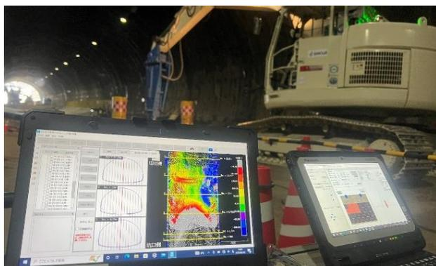
写真-7 リアルタイムに出来形状況を取得する3D LiDAR (監視画面)
