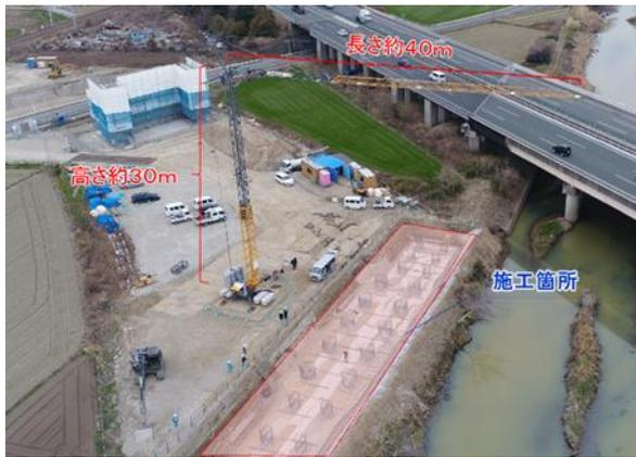
写真-3 定置式水平ジブクレーンの設置状況
