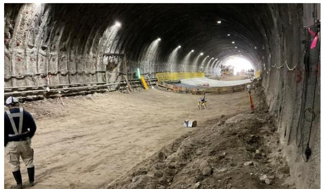
写真-8 自動巡回ロボットによる高精度測量状況
