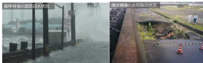
写真-2 護岸背後の道路冠水・水叩陥没状況
