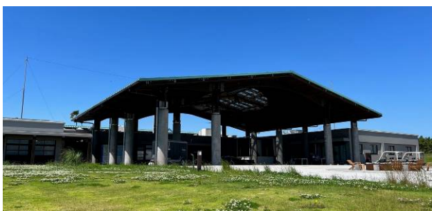
図-7 リノベーションされたセンター棟
