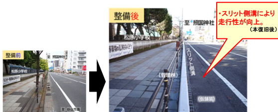
写真-2 スリット側溝による自転車通行空間の整備状況
