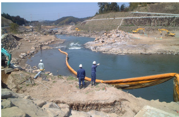
(写真-2) 狭窄部の開削工事
