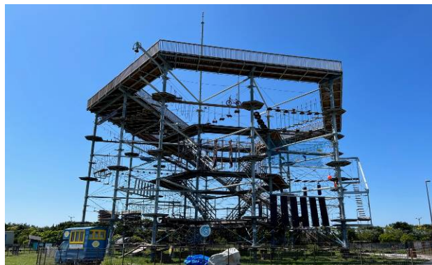
図-9 アスレチックタワー(シー・ドラグーン)
