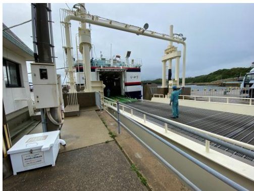
写真-1 フェリー可動橋
