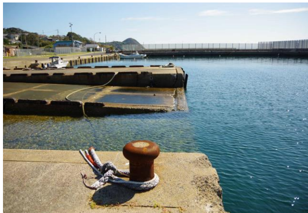
写真-5 傾斜式護岸
