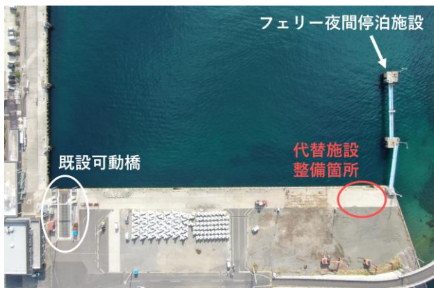
写真-4 代替施設整備箇所
