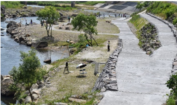
（写真4）景観面、安全性・利便性に優れた整備
