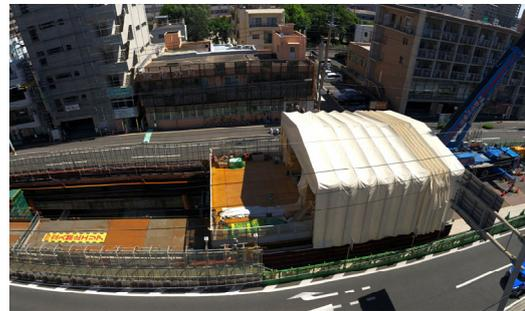
図-16 防音テント設置状況全景
