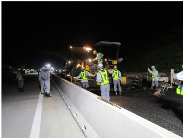
写真-1 排水性舗装施工時の状況写真
