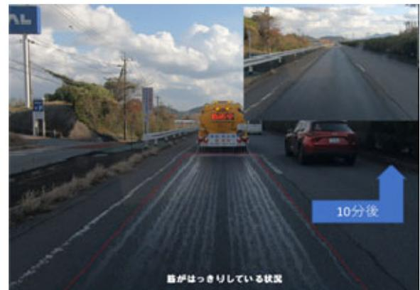
図-13 散水状況検証 (重力式バルブ方式)
