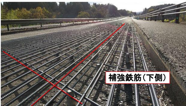
図-7 コンクリート版下面の補強鉄筋組立状況
