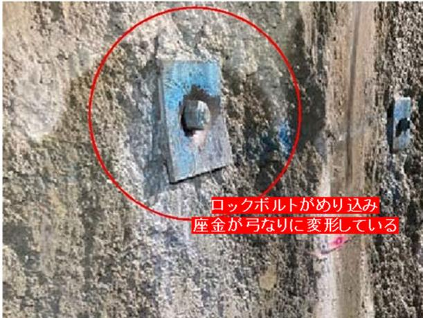
写真-7 ロックボルト頭部の座金変形状況
