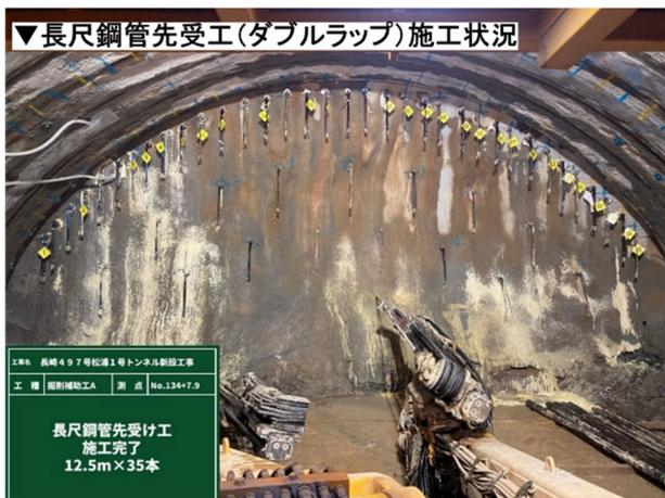
写真-4 長尺鋼管先受工・鏡補強工の実施状況
