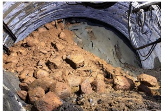
写真-1 左天端部の大崩落状況
