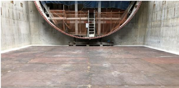
図-7 立坑下作業床(敷き鉄板全面敷)
