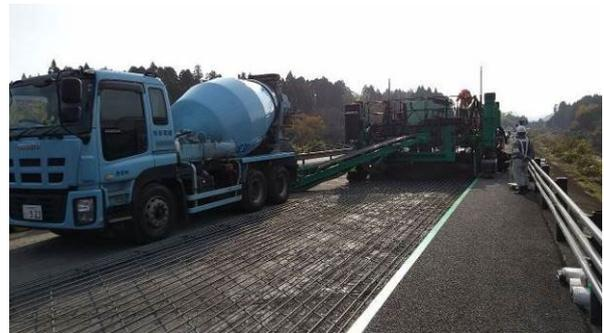
図-9 アジテータ車によるコンクリート荷卸し状況
