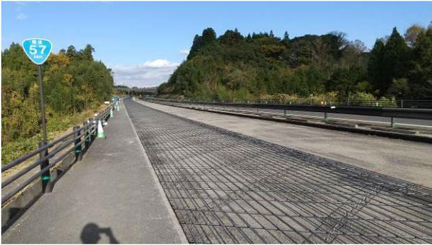
図-6 鉄筋配置状況
