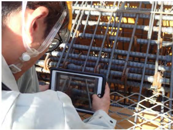
写真8 AI検査システムによる検査の様子
