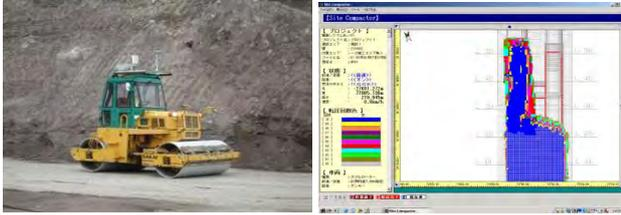
写真6 GPSを利用した施工管理システム(転圧管理)
