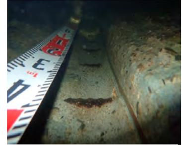
(写真7) トンネル底部の摩耗
