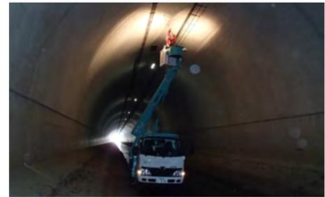
(写真8) 従来の点検（人力による打音検査）
