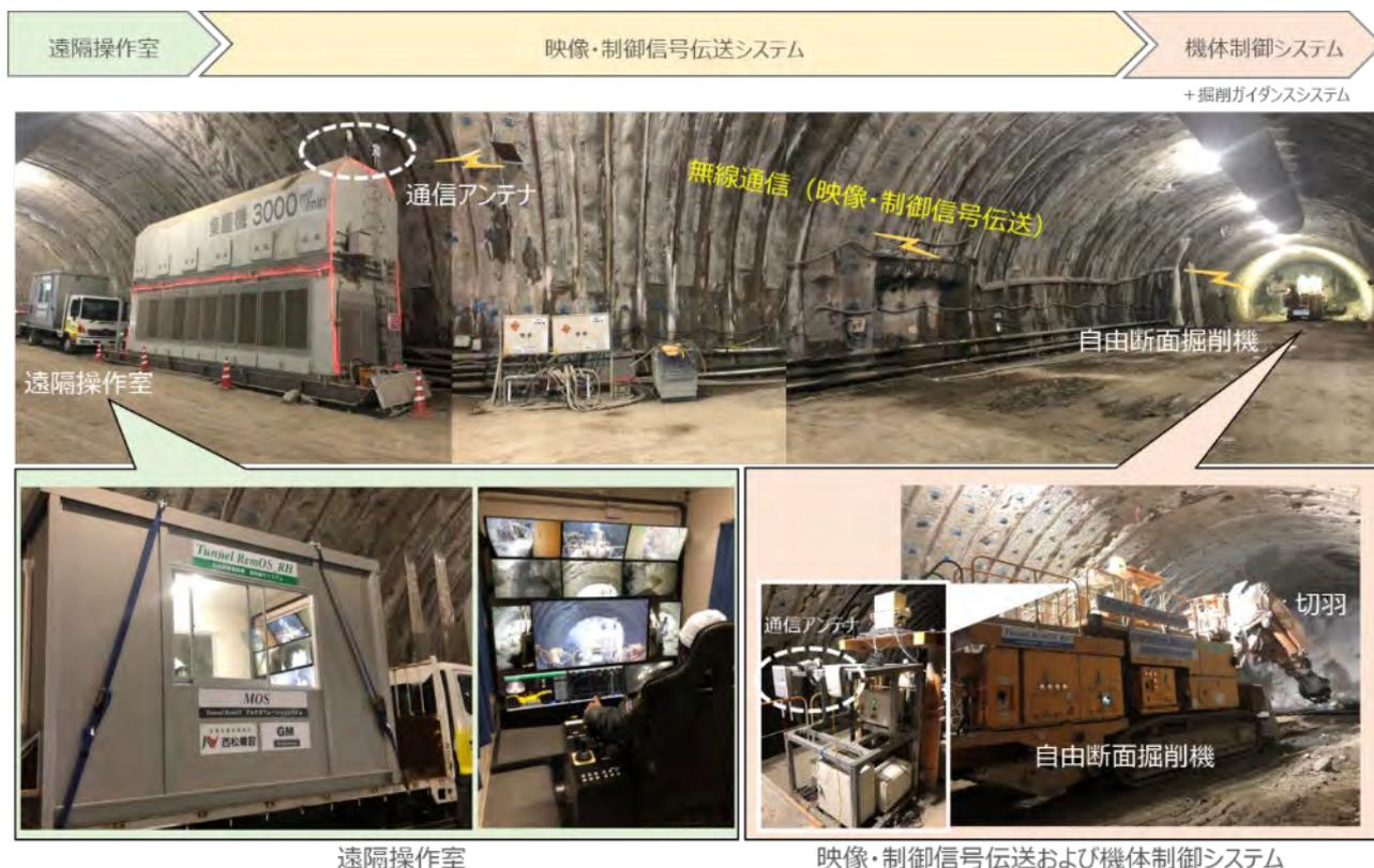
図一2 自由断面掘削機遠隔操作システムの構成
