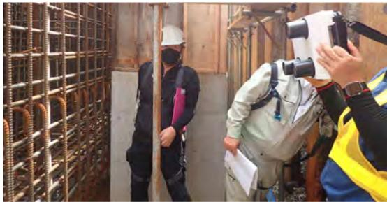
写真-1 配筋検査システムによる検査の様子
