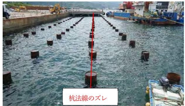
写真-3 既設鋼管杭状況
