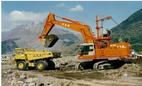
写真3 無人化施工による除石作業(1994年3月)
