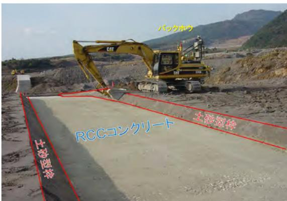
写真4 RCC工法の施工状況
