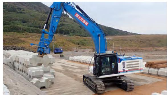
写真9 コンクリートブロックによる補修工事の試験施工状況
