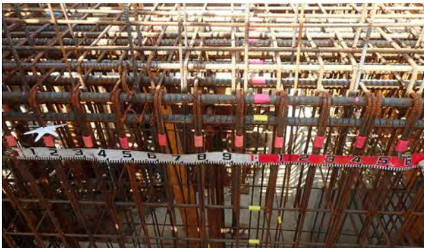
写真-2 従来方法による検査の様子
