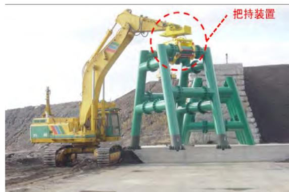
写真5 無人化施工による鋼製スリット設置状況
