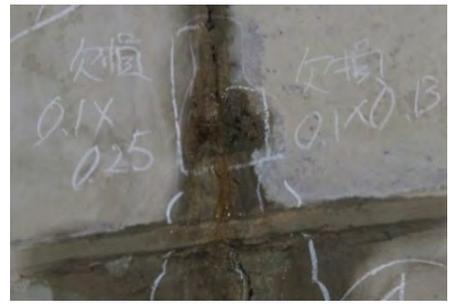
(写真4) 変状 (漏水)
