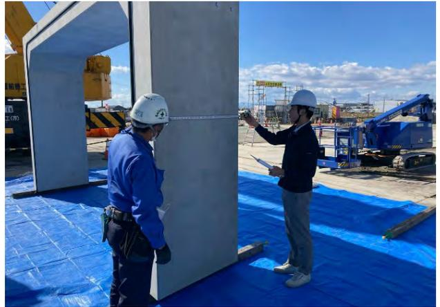
写真-1 函渠の材料確認
