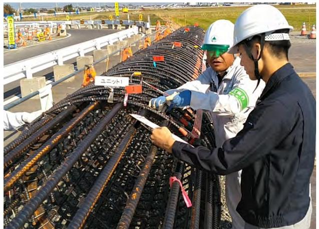
写真-3 鉄筋かご検査状況
