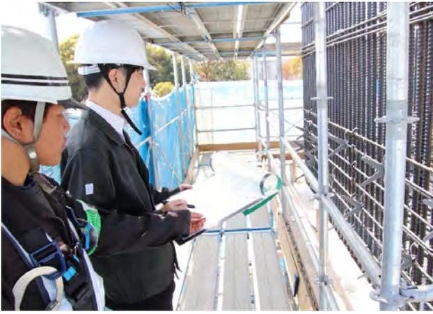
写真-4 下部工配筋状況
