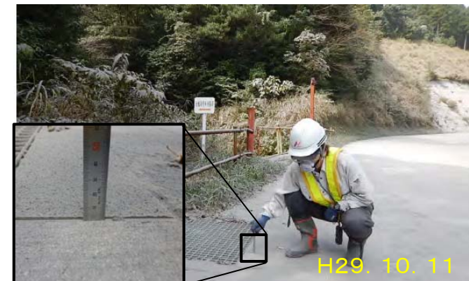
地上からの現地調査状況
