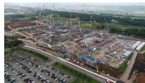
菊陽町で建設中のJASM工場（令和4年9月撮影）
