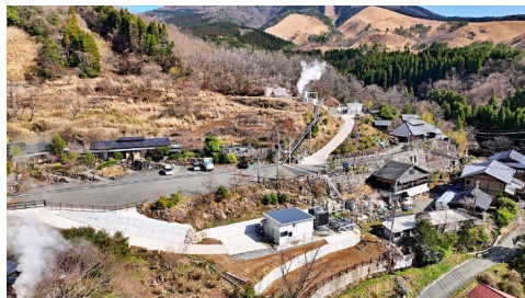
旅館山翠敷地内にある地熱発電所の様子
