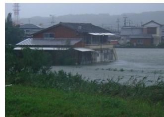
平成17年9月の浸水状況(宮越樋管付近)
