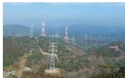
大分県日杵市 鉄塔の様子
