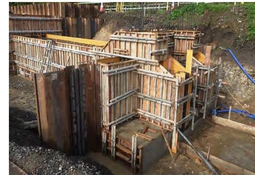
型枠工（省力化構造）
