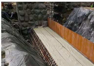
仮締切工（砂防コンクリート締切）
