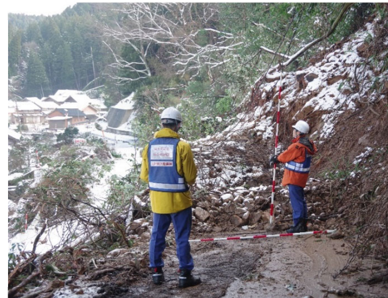
△現地調査状況（輪島市町野町）
