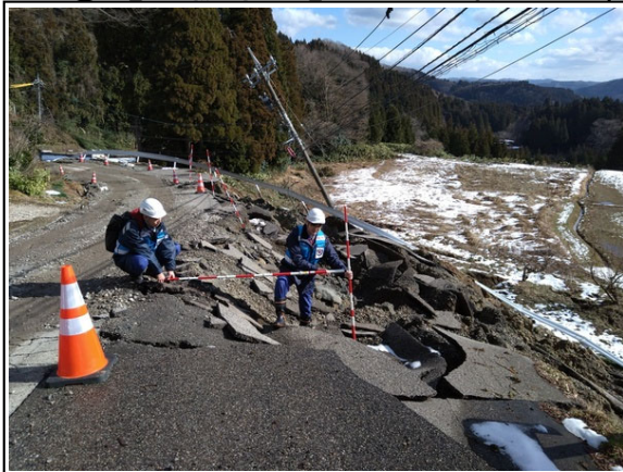
地盤振動により法肩崩壊
