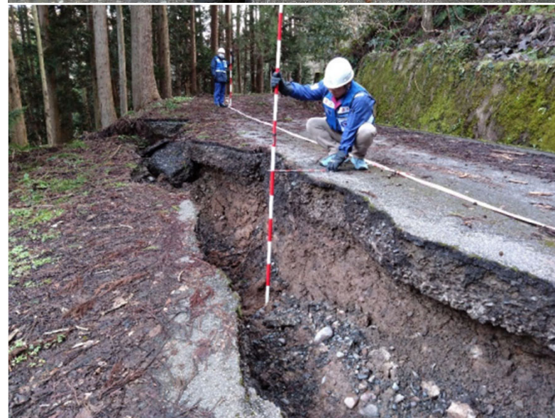
▲被災状況調査状況
