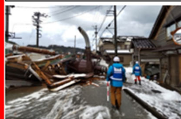
被災状況調査
