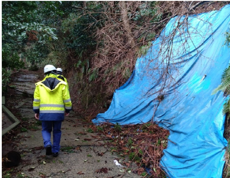
△現地調査の状況（輪島市）
