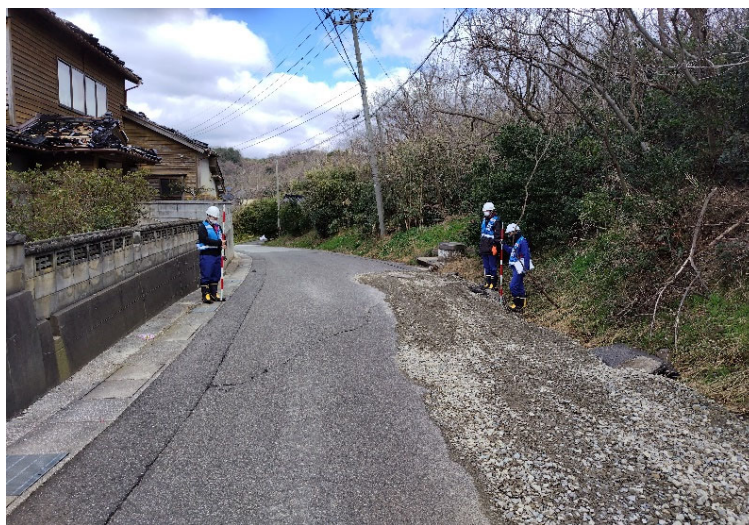
▲主な被災状況（マンホールの隆起、舗装損傷）
