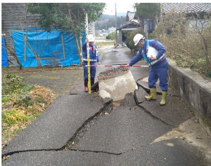
▲主な被災状況（マンホールの隆起、舗装損傷）
