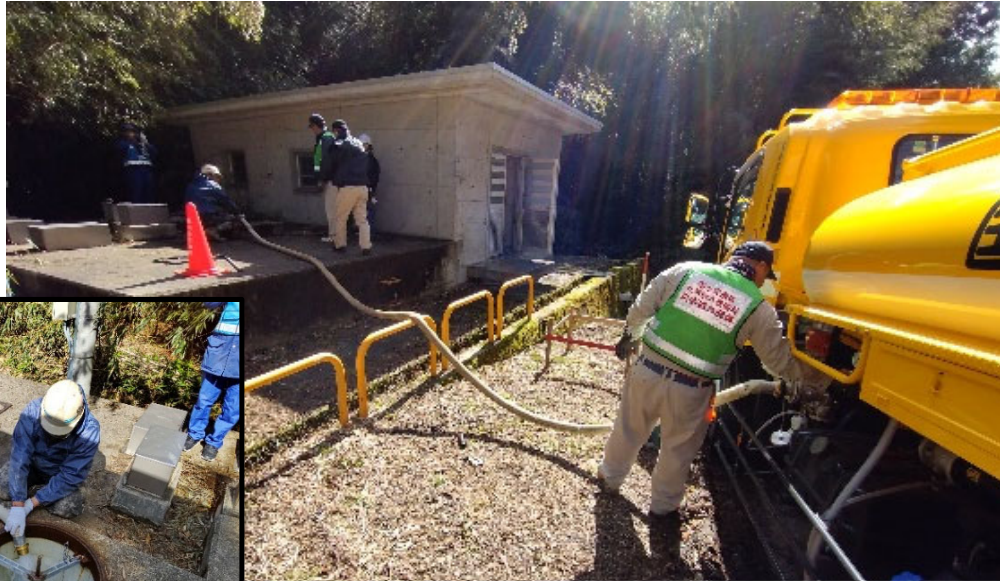
上水送水施設への通水確認用水の給水
