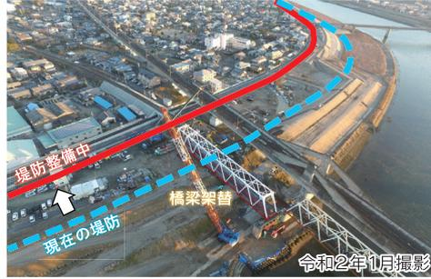
流下断面拡大のための堤防(引堤)を整備
