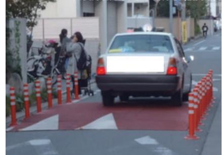
(※)ハンブ:自動車の走行速度を低減するために道路上に設けられた凸型の構造物
