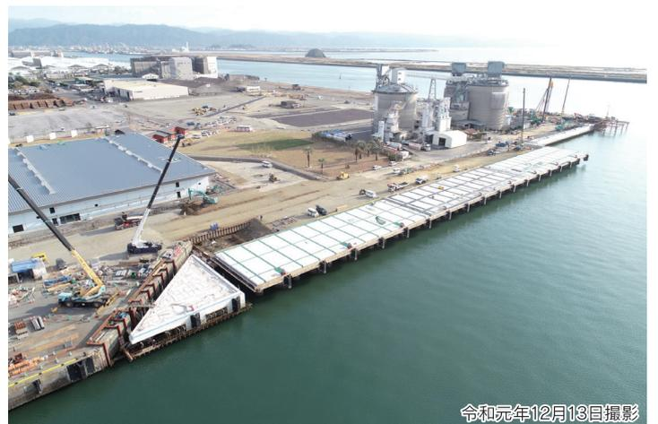
緊急物資輸送を支える耐震強化岸壁の整備(八代港)
