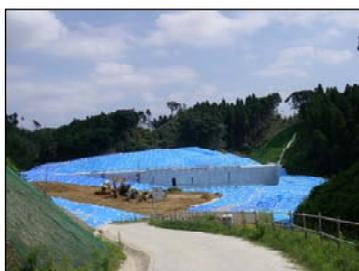
▲盛土箇所の対策前の様子。降雨等による有害物質の流失を防ぐためにシートで覆っている。
