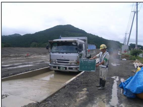
① 洗浄槽通過による泥落とし
