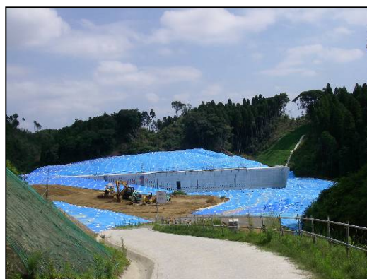
▲盛土箇所の対策前の様子。降雨等による有害物質の流失を防ぐためにシートで覆っている。
