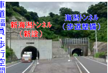
▲ 新海潟トンネル (H25供用)
