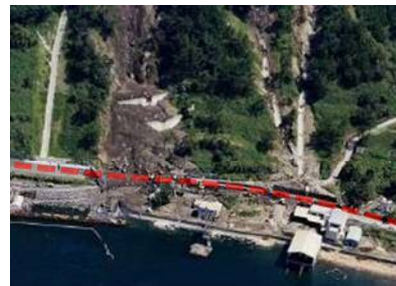
▲ 旧道の被災状況 (平成5年台風13号)
