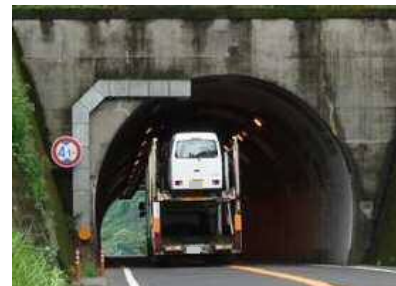
▲ 狭小トンネル (幅員狭小)
