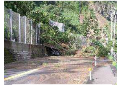
▲ 旧道の被災状況 (平成17年台風14号)
