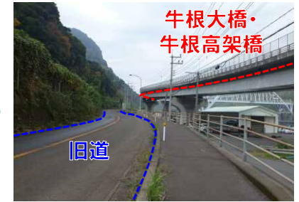
▲ 牛根大橋・牛根高架橋 (H19供用)
