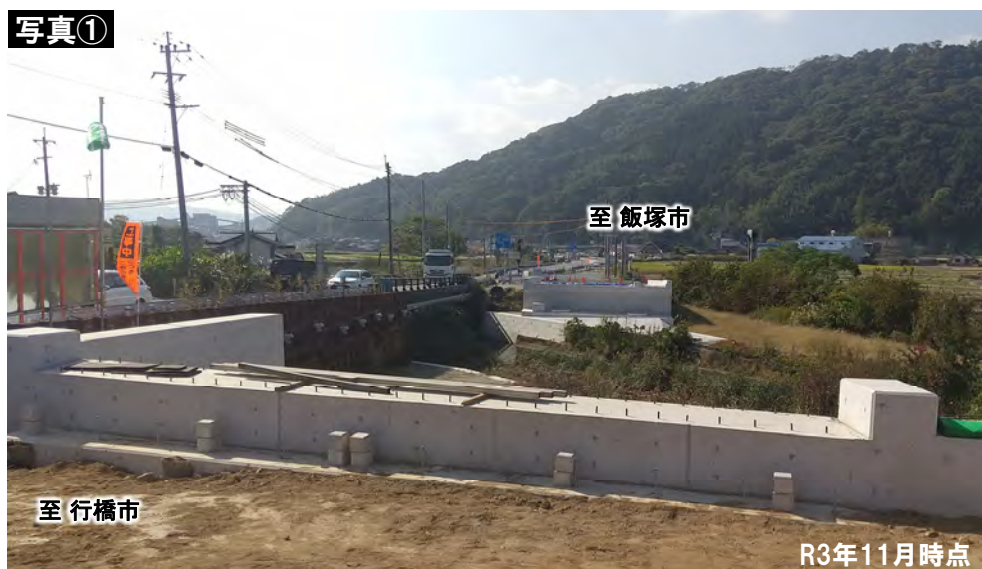
▲ 新朝倉橋下部工の状況
