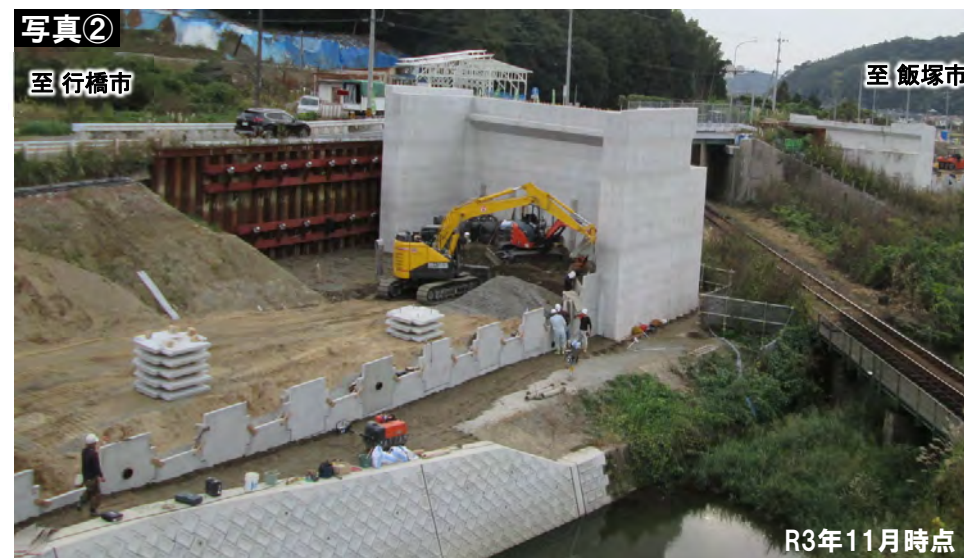
▲ 鏡山跨線橋の施工状況
