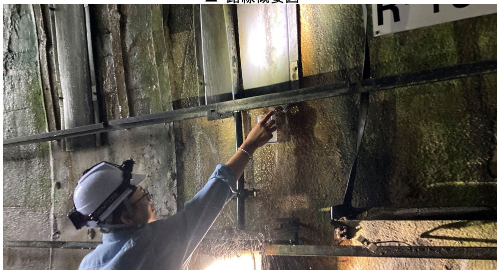
▲ 漏水調査の実施状況
