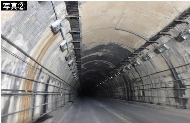
▲閉鎖トンネル全景[行橋市側]
