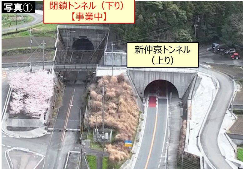
▲トンネル坑口[香春町側]
