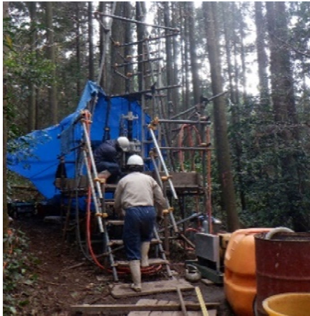
ダム周辺の地質調査状況
