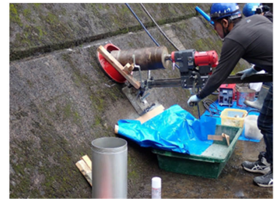
既設堤体健全度評価のための ボーリングコア採取の状況
