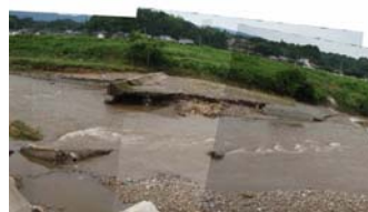
柳原堰(農林施設)の損壊状況
