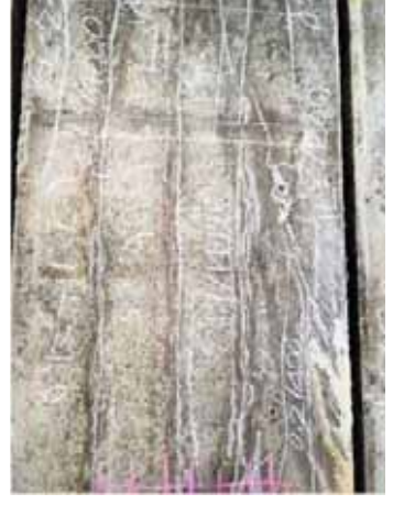
床版下面(中空床板橋)のひびわれ
