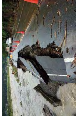
写真①：H24.7被災（路肩崩落）
