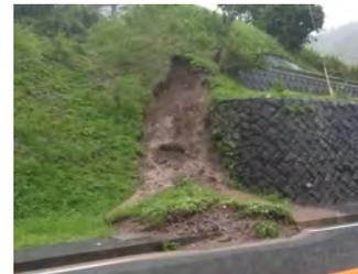
写真①：法面崩壊状況
