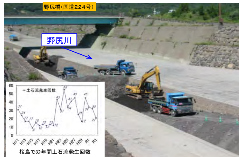
野尻川の除石状況
