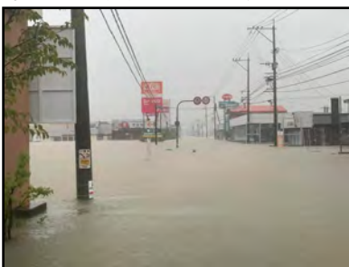
令和元年8月洪水(牛津川越水状況)
