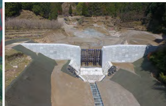
流木捕捉効果の高い 乙石川25・26砂防堰堤
