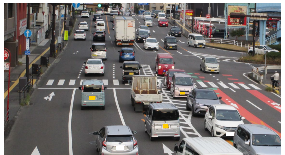
国道225号産業道路入口交差点（鹿児島県鹿児島市）
