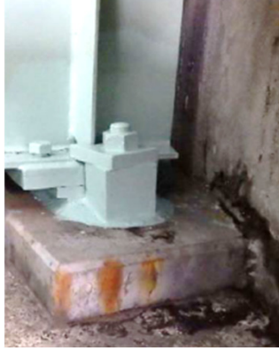
支承塗装塗替え
