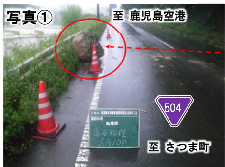
写真① ▲豪雨により落石が発生し交通遮断
