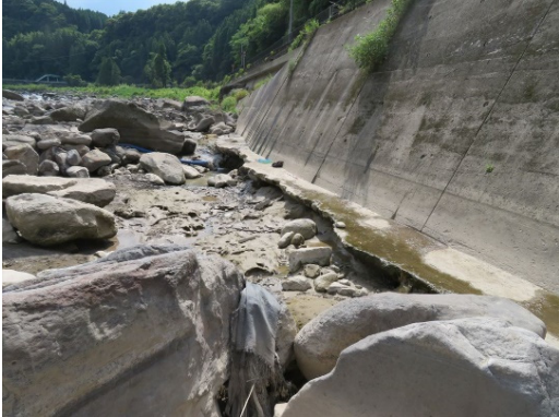
流失防止箇所(全景)
