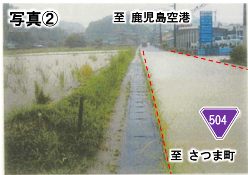
写真② ▲豪雨により路面が冠水し交通遮断
