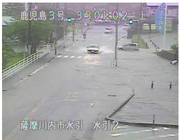
写真②：大雨による冠水状況
