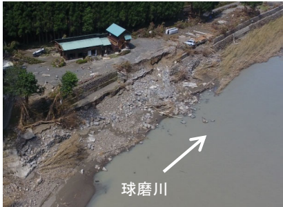
▲球磨川(52.0k付近)における護岸の被害状況(球磨郡球磨村)
