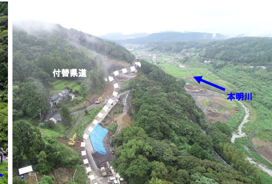
付替県道施工状況 (R4. 9撮影)
