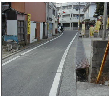
写真② 整備前
