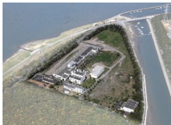
大在水資源再生センター
