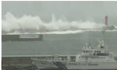
厳原地区 防波堤(北)
