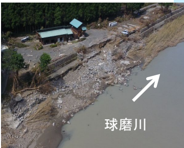
▲球磨川(52.0k付近)における護岸の被害状況(球磨郡球磨村)
