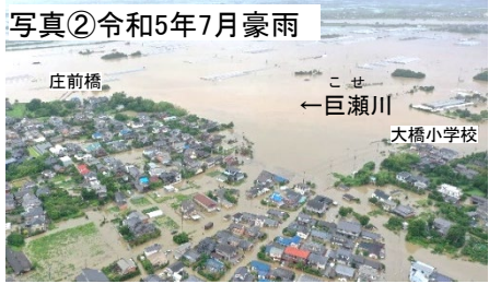
巨瀬川4k000付近の浸水状況
