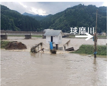
▲球磨川56.4kの堤防決壊状況(人吉市)
