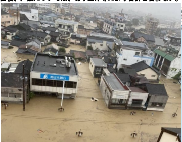
▲球磨川(61.4k付近)右岸の人吉市の浸水被害状況
