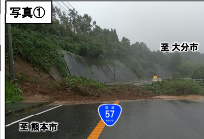
▲ R4.9 台風14号の被災状況
