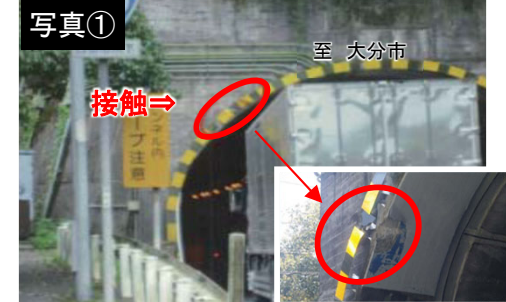
▲断面不足で坑口部へ接触
