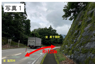
▲線形不良箇所
