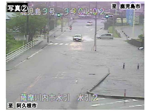
▲ 大雨による冠水状況 (R2.5)
