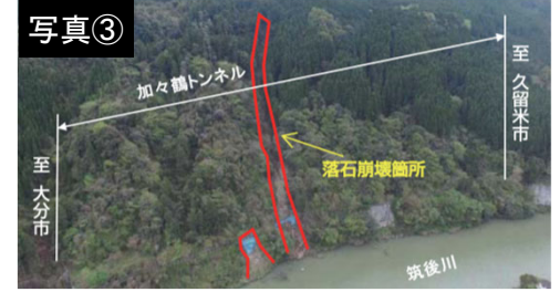
▲H28熊本地震による被災状況
