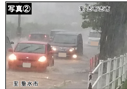
▲H29.7冠水状況
