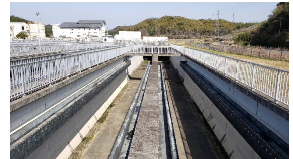
水処理施設増設箇所
