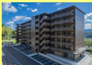
災害公営住宅整備 (R5年度完成)
