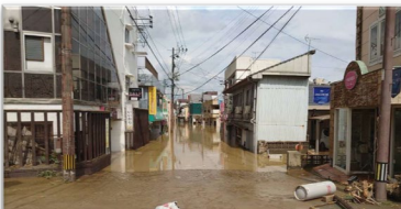
人吉市(紺屋町地区)浸水状況
