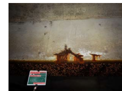
箱崎ふ頭地区 岸壁(水深12m)
