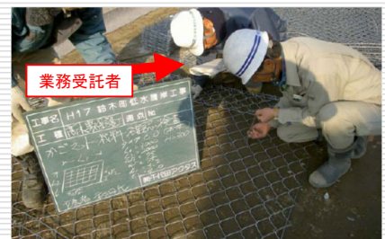
(河川護岸用かごマットの材料確認)
