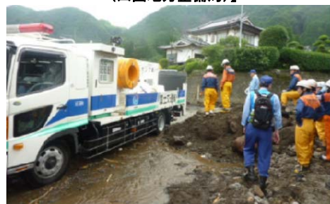
【TEC-FORCE の排水ポンプ車による支援 (四国地方整備局)】
